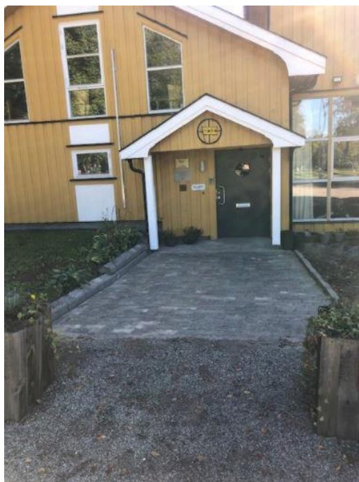
Ny inngangsdør, området utenfor hevet og nytt plattå støpt og brosten lagt.
