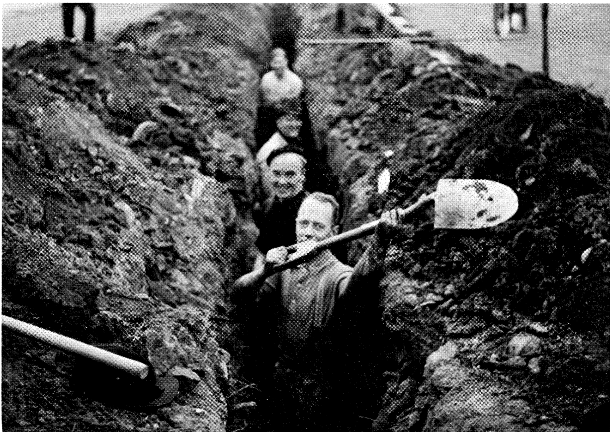
Glade roere legger inn gassledning (1938).
