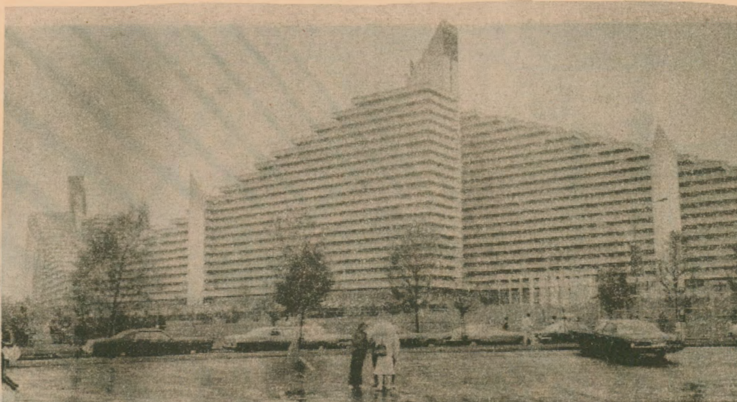
OL-landsbyen, eller retttere: De som bygde den, skal tiltales umiddelbart etter at OL er slutt.
