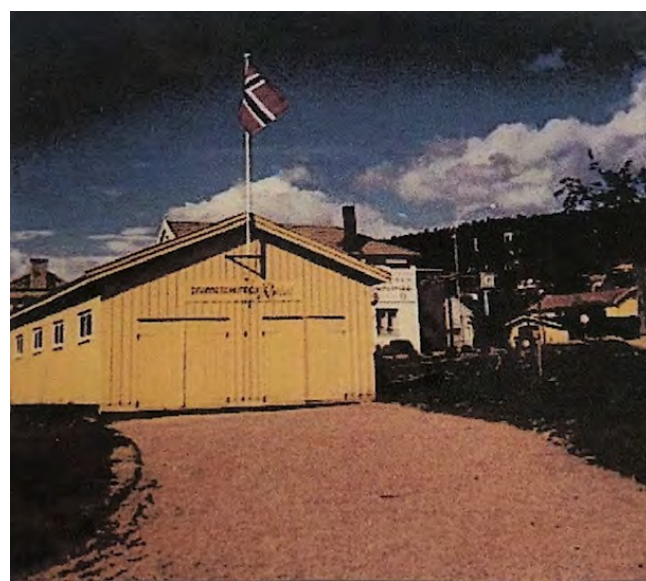
Drammens Kvinnelige Roklubb, Øvre Storgate 25a før rivning sommeren 1996. Fra båthallen på østsiden.
