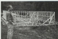
Magne Sølvsberg på kontroll under reisingen av det nye båthuset på Bogstad.
