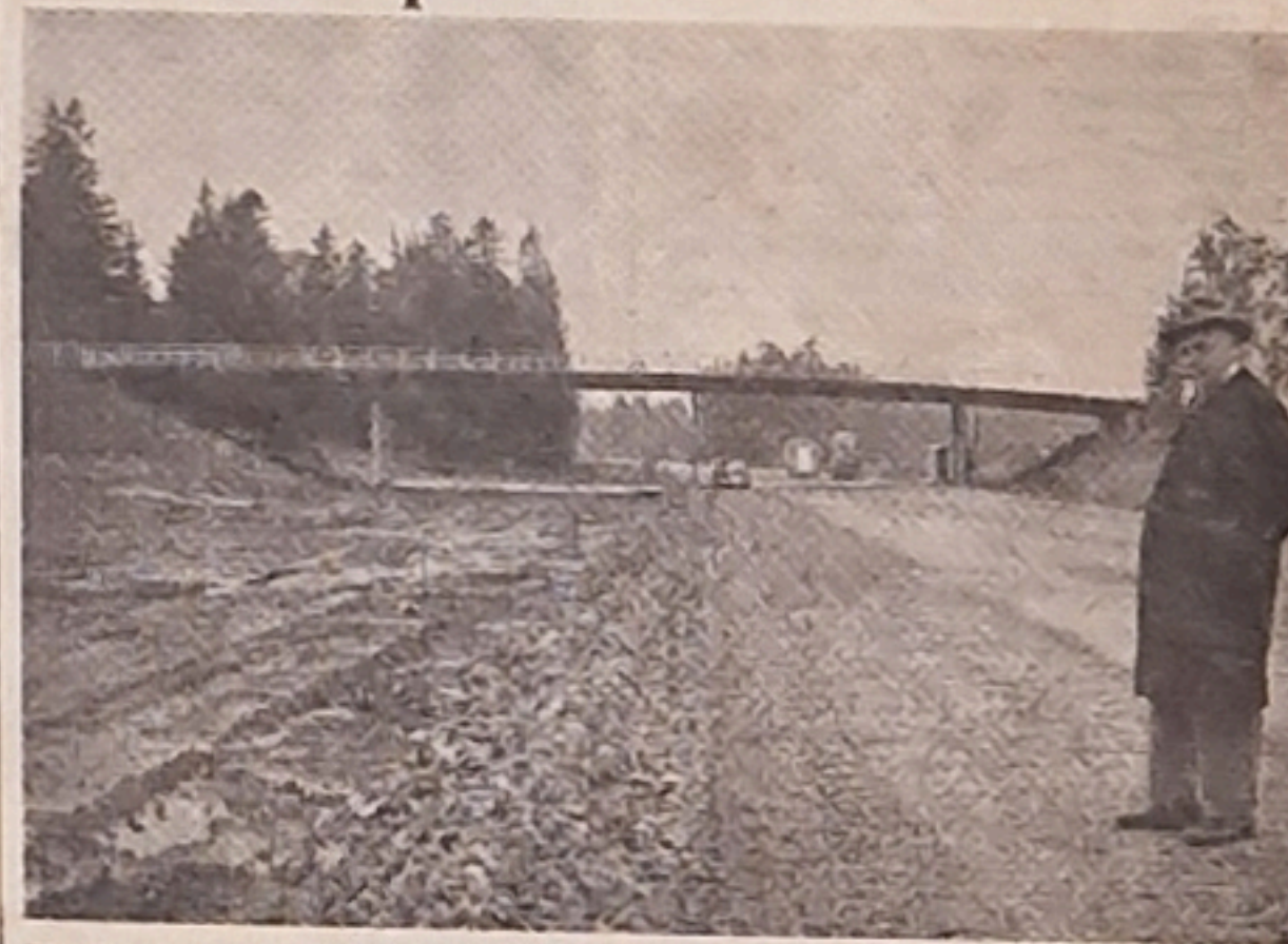
Strekningen Patterød-Halmstad er bygd med to kjørebane, men vil senere bli fullt utbygd til motorvei med fire kjørefelt og midtdele. Derfor er overgangsbromene bygget så lange slik at man får plass til de neste kjørefelt uten å forandre broene. Veisjefen i Østfold, Olav Benterud i forgrunnen.
