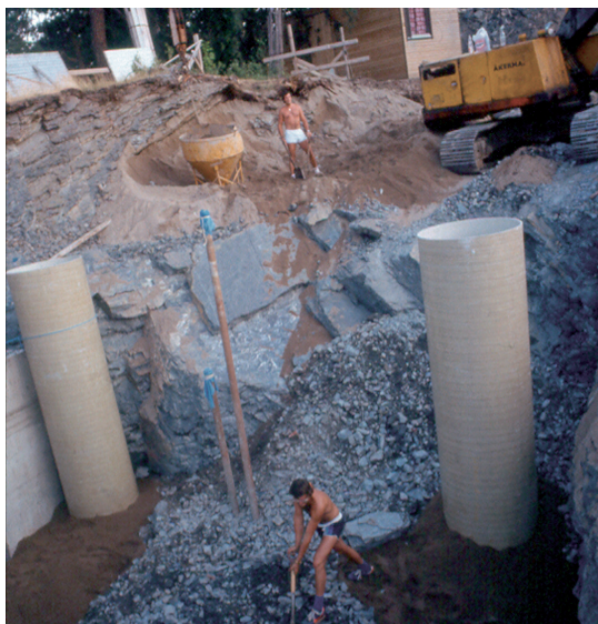
Erstatningssummen for det gamle klubbhuset var brukt opp lenge før det nye klubbhuset sto ferdig. Her holder man på å montere rørene til robassenget på dugnad.
