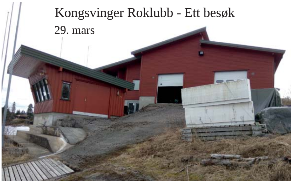
Måltårn, båthus og en bratt bærevei
