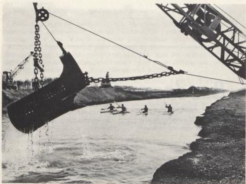
Fra arbeidet med å grave den 2,5 km lange og 150 meter brede kanal som skal bli bane for konkurransene i roing og kajakk-padling ved de olympiske leker i München 1972.
